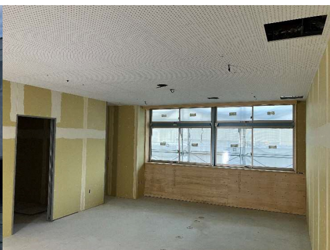
内装工事も徐々に仕上がってきています。
