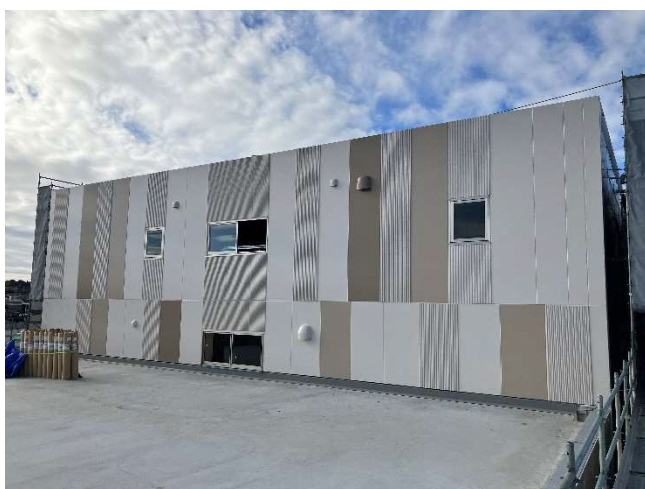
東面の一部外壁が完成しました。
